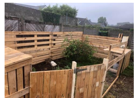
Réalisation du nouveau poulailler du foyer
